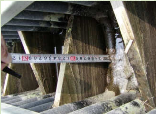
使用途中の堰板
