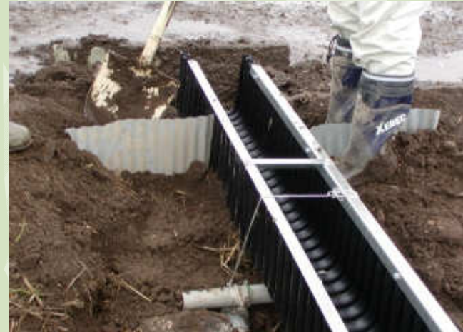
畦漏水防止の事例
