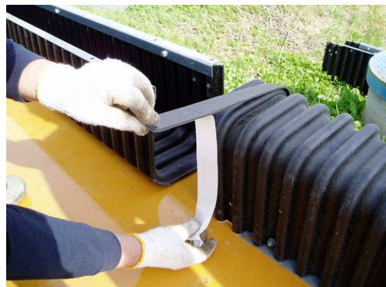
止水パッキンを接続部の中央 凸部に貼り付ける。
