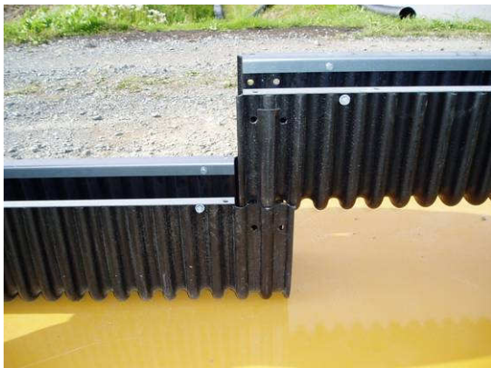
下流側 U 字溝に上流側 U 字溝 を重ね合わせる
