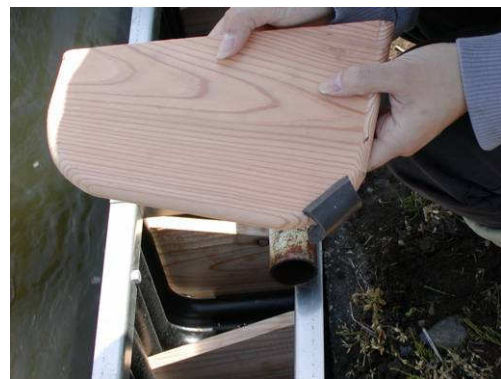
堰板と漏水補強
