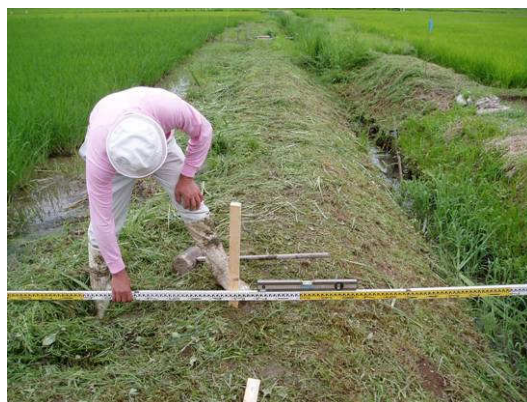
水平器で水平を確認する
