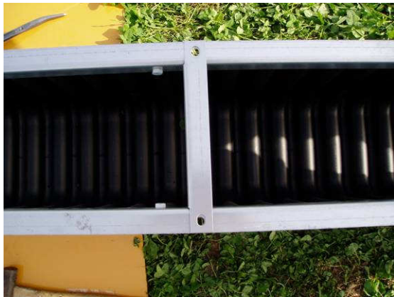
上部固定アングルを設置する
