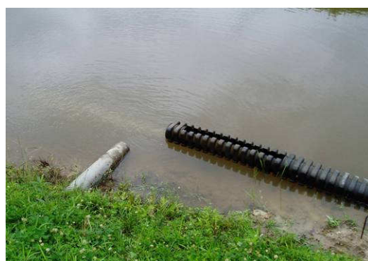
水面に浮かして接続させる
