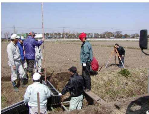
並行して梯子土台設置の測量
