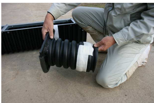
ソケットに止水パッキンを貼り付ける
