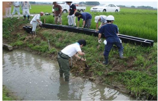
水路法面の掘削
