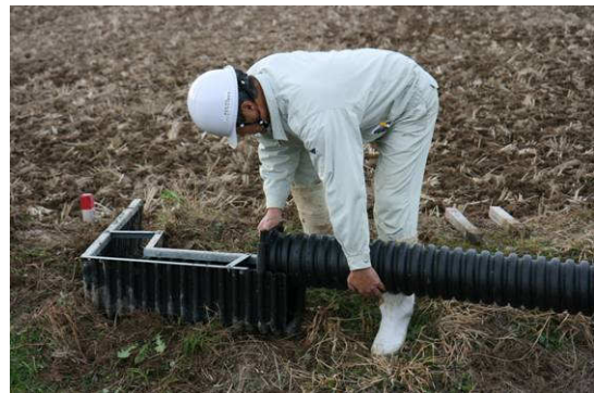
水平Lボにソケットを挿入中
