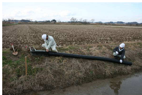
設置勾配の調整
