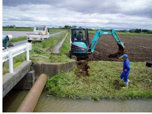
ミニバックホウ（掘削土量が多い場合）
