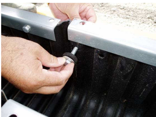
U 字溝の側面をボルトで固定する
