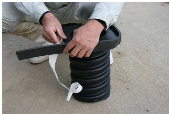
止水パッキンの貼り付け
