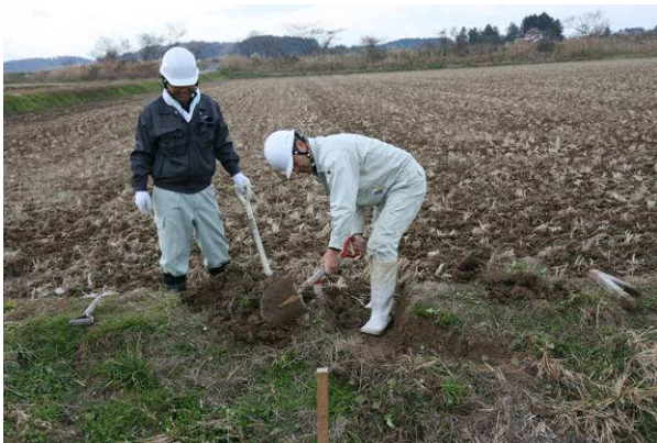
水田との取り付け部の掘削中
