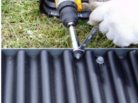
上部固定プレートの固定中（スパナで固定しインパクトレンチで締める）
