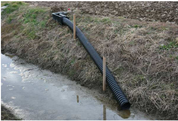
スラントで設置勾配の確認
