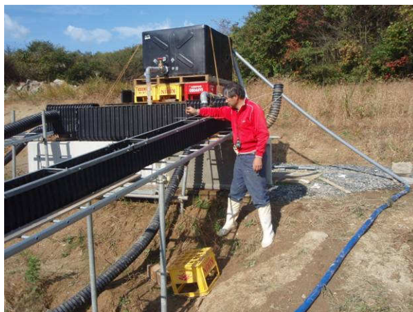
水位流量測定装置
