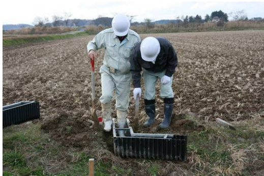
取付け部の掘削
