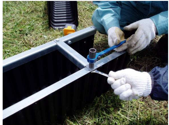
上部固定アングル固定中
