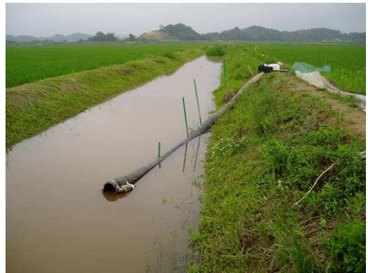
振れ止め杭の設置
