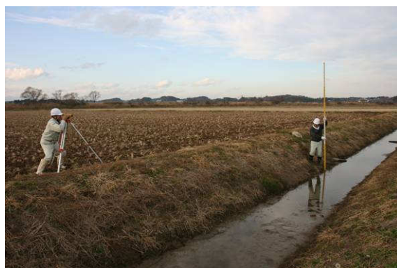
水路の横断測量
