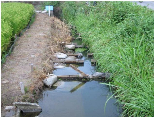
写真3 切り欠き型の水田魚道
