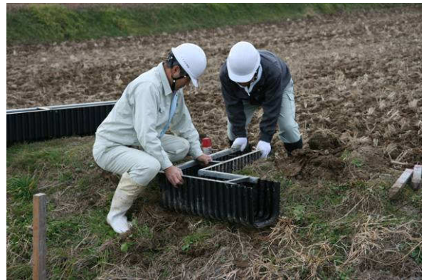
水平Lボの据付け調整
