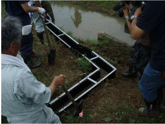
仮通水し漏水確認
