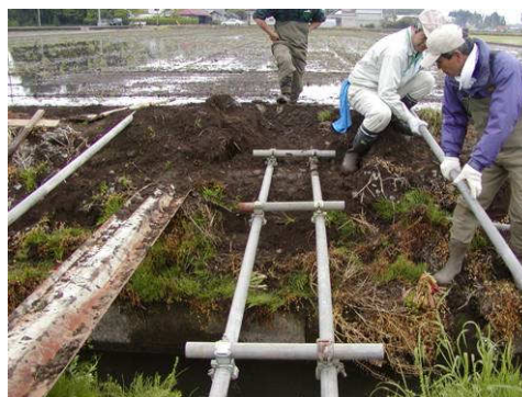
梯子土台の設置
