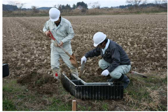
取付け部水平エルボの設置
