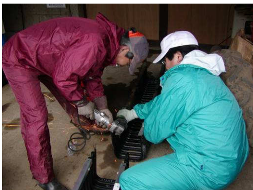
設置延長に合わせてサンダー等で切断
