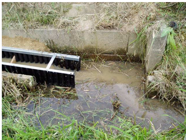
組立柵渠の側板を取外し拡幅した事例
