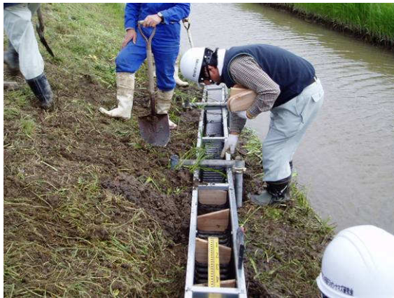
仮通水し漏水確認
