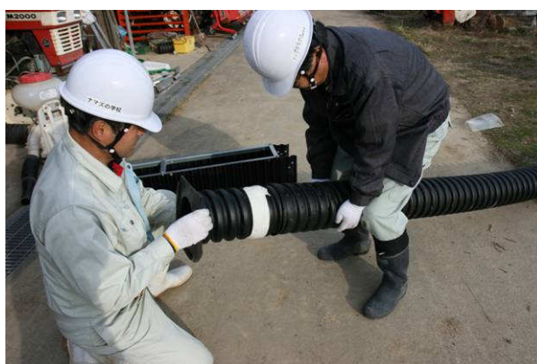
ソケットに丸型管をねじ込み開始 2人で行う必要がある
