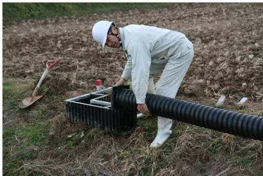
水平Lボにソケットを挿入
