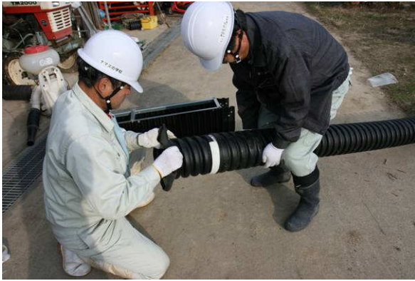
ソケットに丸型管をねじ込み中
