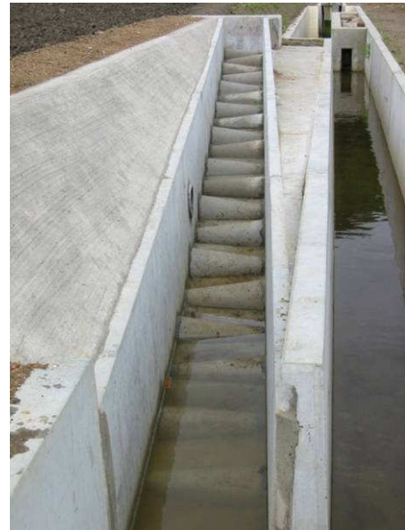
写真2 ハーフコーン型の水田魚道
