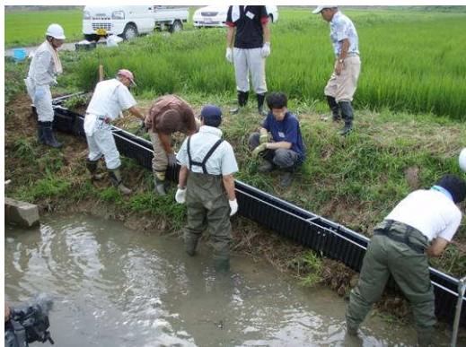
取付け部水平エルボの埋め戻し
