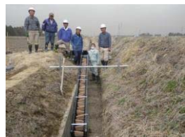
アグリネット西下ヶ橋
