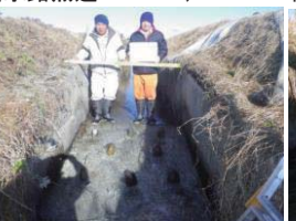
同左(水路魚道NO2~4)
