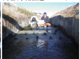
同左(水路魚道NO5~6)
