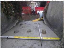
同左(水路魚道NO1)
