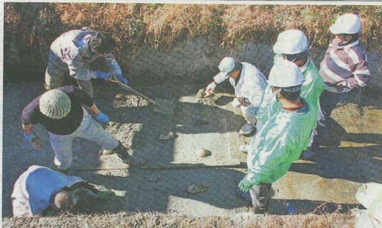
①今年度から取り組んでいる「水路魚道」の設置作業(17日、宇都宮市で)、②片斜面モデル手前に向け、左上から右下へ傾斜をつけてコンクリートを打ち、粗石を埋め込む他、くぼみを設けて魚の遡上を手助けする方法
