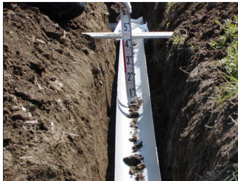
写真2. 塩ビ管の埋設深 40cm
