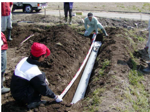
写真1. 塩ビ管の埋設
